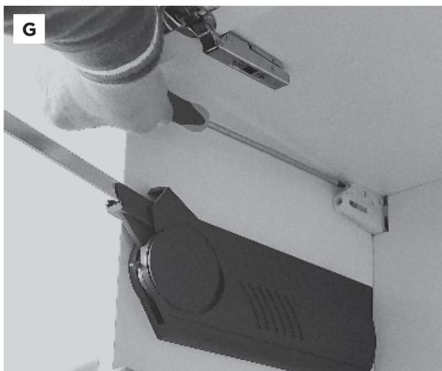
Utilizzare la vite superiore dell'attaccaglia per regolare il pensile in altezza e mettere il tutto a bolla (G)
