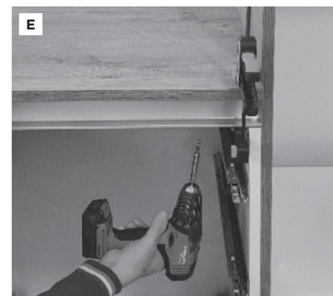
Per i piani in laminato è consigliabile il fissaggio tramite viti.
