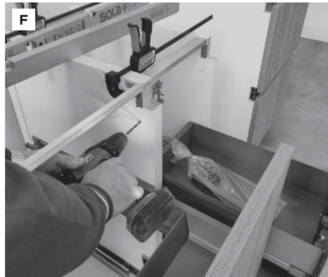
Per l'unione delle basi Armony realizza una preforatura. Utilizzare trapano con punta da 5,5 mm per completare fori (F) (G).
