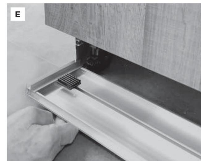
Applicare gli **elementi di fissaggio** sugli zoccoli laterali. Posizionare lo zoccolo sul pavimento nella posizione corretta e portare gli elementi di fissaggio di fronte ai supporti per zoccolo (C). Alzare lo zoccolo e agganciare supporti con elementi di fissaggio.
