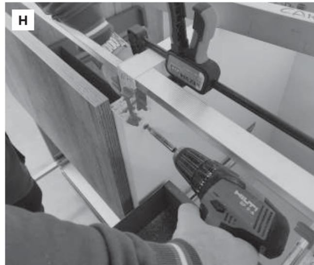
Avvitare con avvitatore e bloccare lato opposto tramite cacciavite (H). Procedere per tutti i fori di unione: due per le basi, due per i pensili e tre per le colonne.
